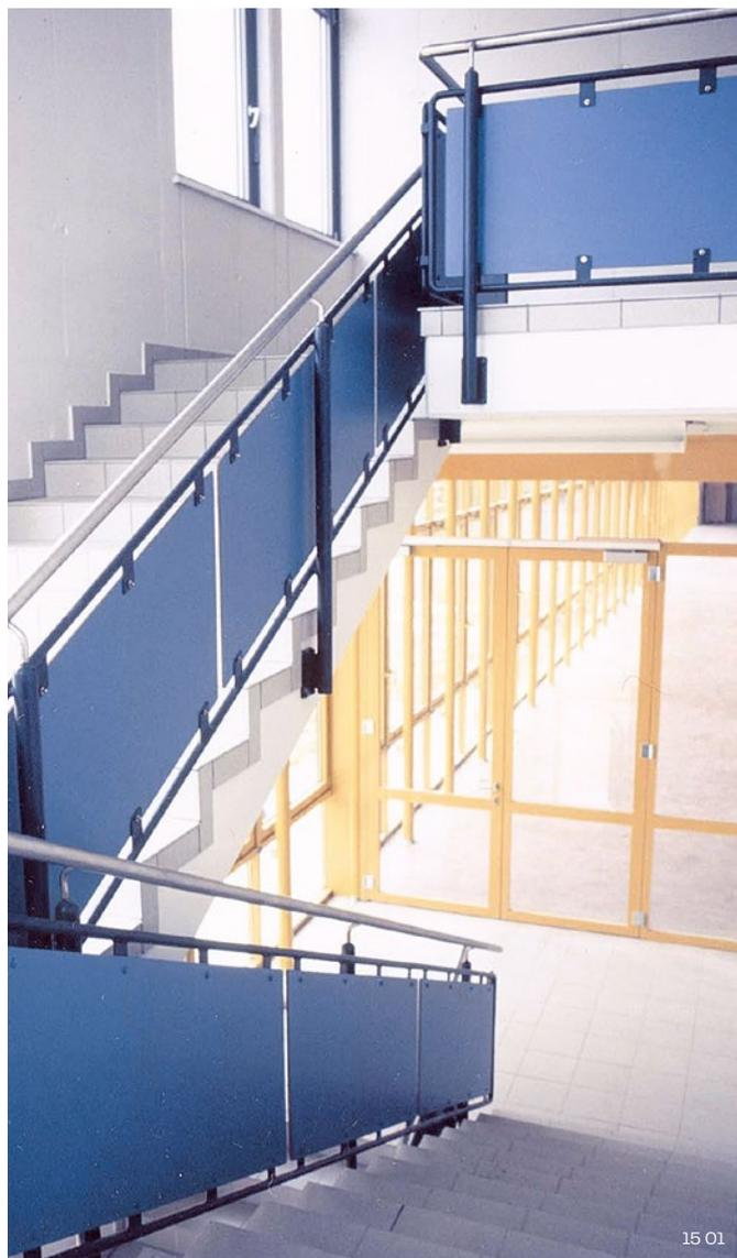
15 01 Rellenos de barandillas sujetos mecánicamente
