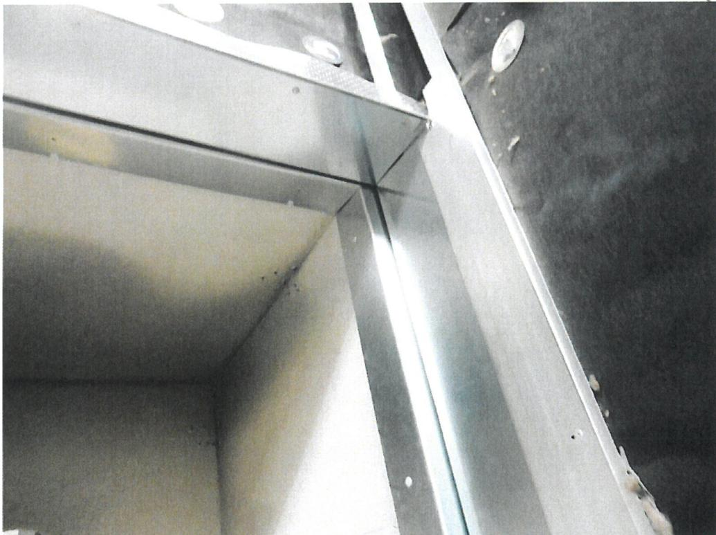
Bild 4 (P1110012): Detail Sturz- und Laibungsverblechung
